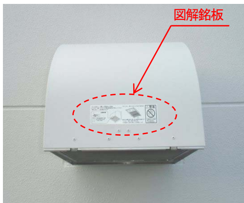
写真：屋外メンテナンス簡易タイプウェザーカバー
