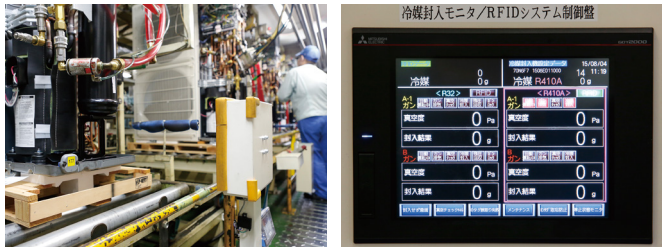
■冷媒ガス封入工程。タグの情報を自動で読み込み、作業者への指示をGOTOに表示。
