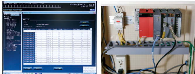
■SA1-Ⅲは現場のデータを収集するだけでなく、さらに上位の生産管理系のシステムと連携。最適な生産計画に必要な現場情報をフィードバック。
